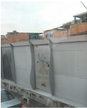
Cercas de "isolamento acústico".
